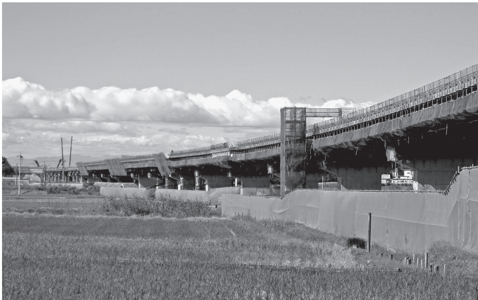
完成まじかの圏央道
