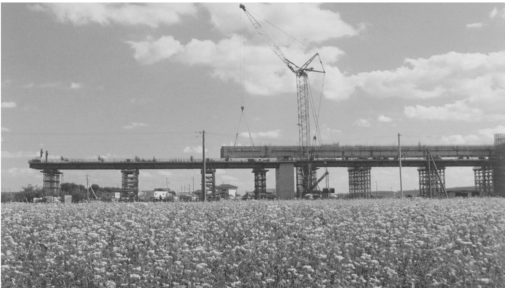
平成26年度開通予定の圏央道利根川橋脚工事（塚崎正面より撮影）
