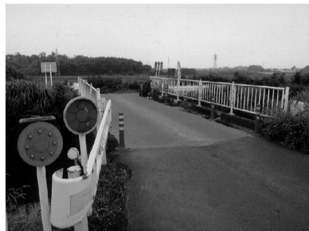
横塚地区宮戸川橋梁
