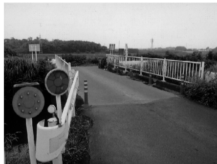
横塚地区宮戸川橋梁
