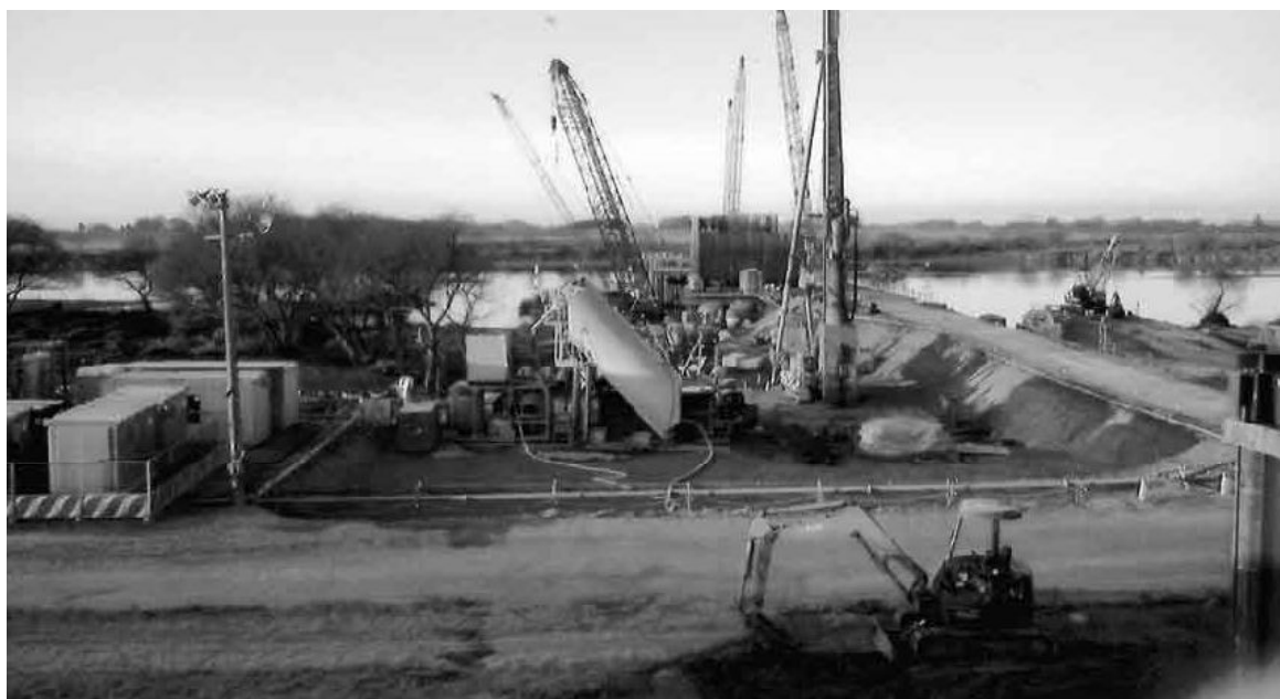
圏央道利根川橋脚工事現場塚崎地内
