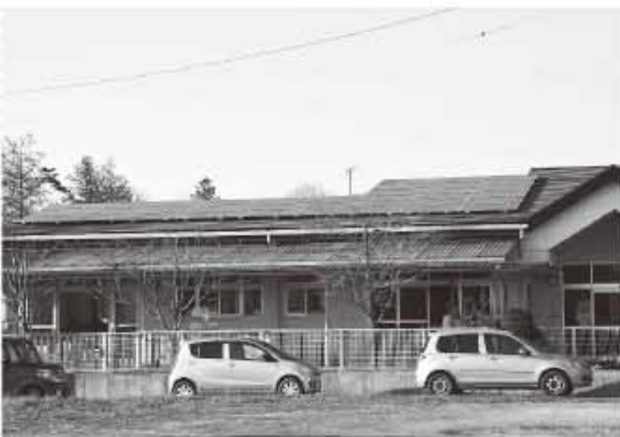
▲ひまわり保育園などの屋根にソーラーパネルを設置
