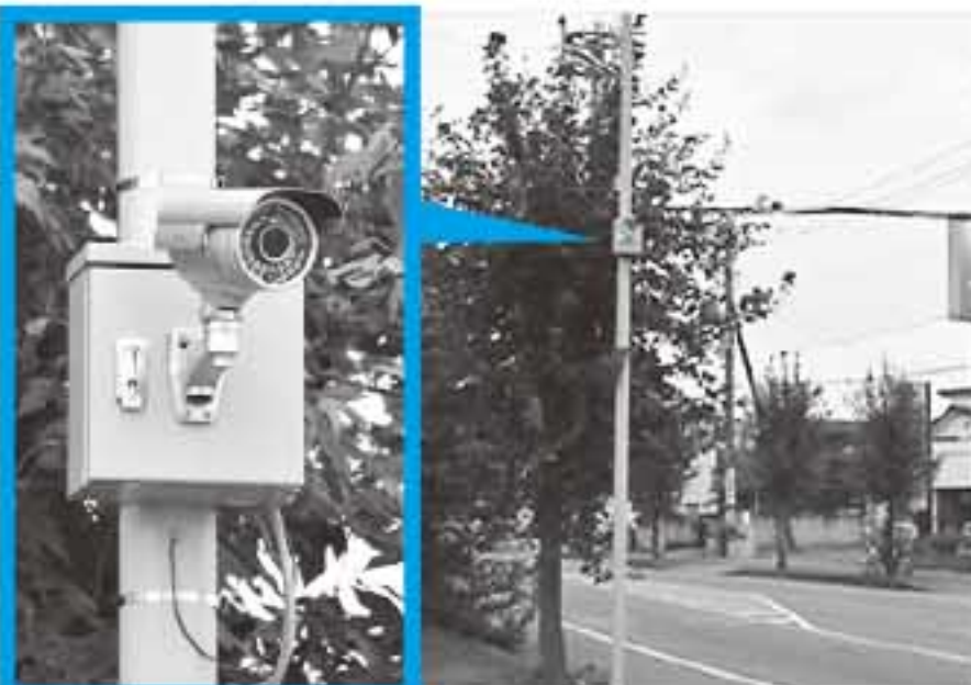
▲防犯カメラの設置
