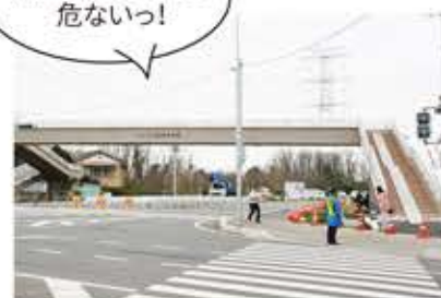
国道354号線と町道1-4号線が交差する「境古河IC北」交差点に新設されました
