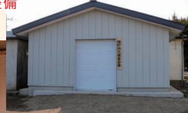
町内5校の小学校に整備された防災備蓄倉庫
