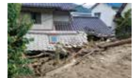
倒壊を逃れても家屋内へ土砂が流入し甚大な被害に
