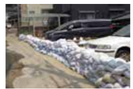
水路が埋まった影響で水が道路上を流れるため、設置されている流入防止の土のう
