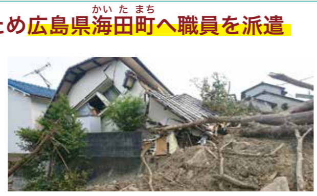
土砂崩れにより岩や流木の直撃を受け、倒壊した家屋
