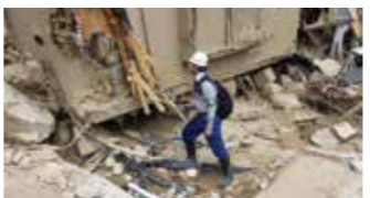
外観目視により家屋外周を確認し被害状況を把握する
