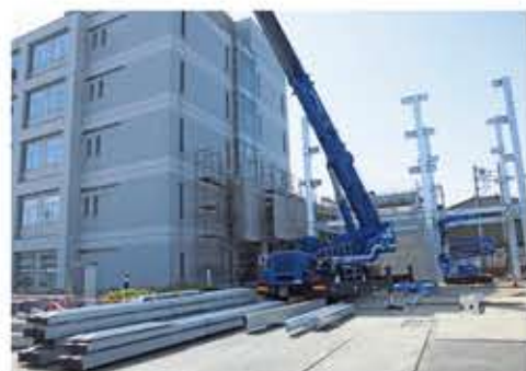
建設風景 (平成30年5月)
