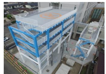
(水害避難タワー)
