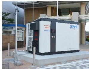
(水素ステーション)
