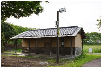
(防犯カメラの設置)
