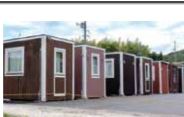
岡山県倉敷市では、災害救助法における「応急仮設住宅団地」として認められた41戸を展開
