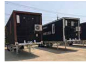
平成30年7月、岡山県倉敷市にボランティア本部用として設置されたムービングハウス。境町がふるさと納税によるクラウドファンディングによって移動資金を募りました
