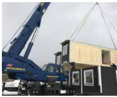
すぐに移動でき、設置できるため、被災地への迅速な対応を可能にします
