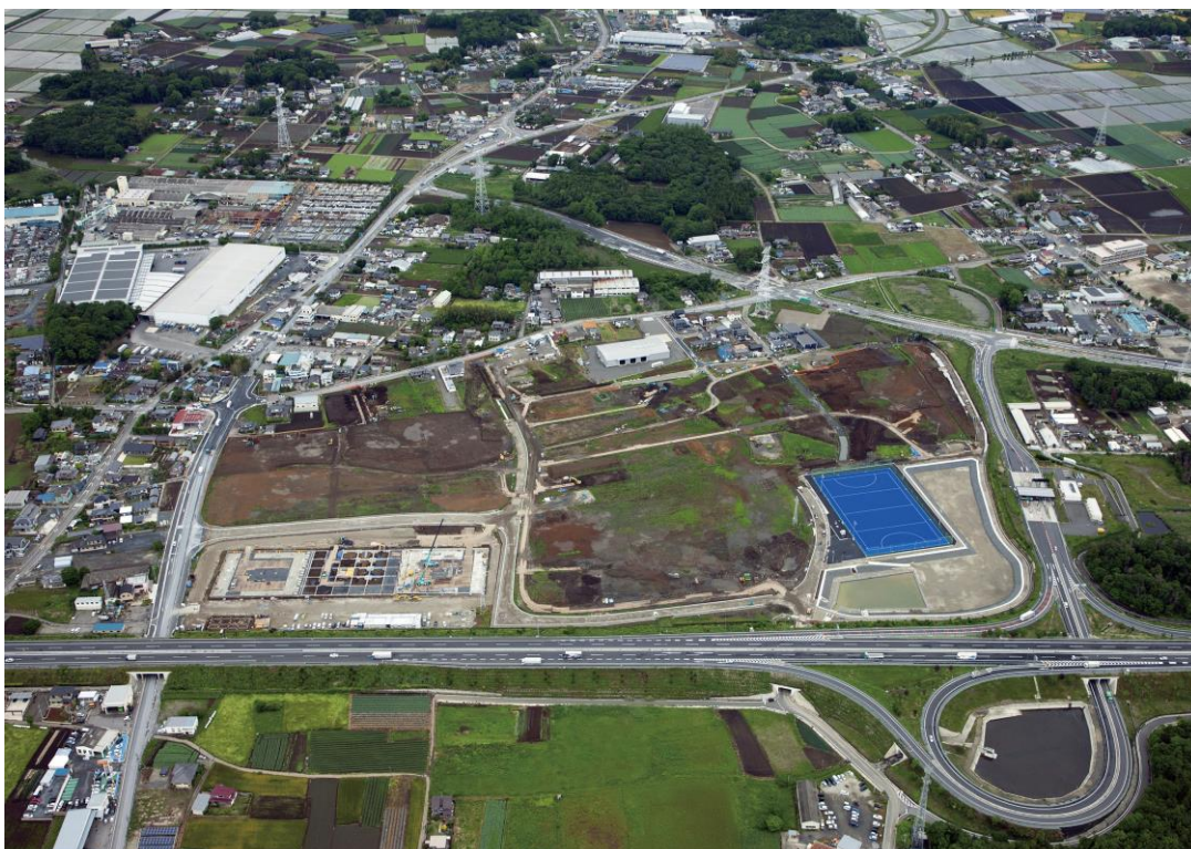
■境古河インターチェンジ周辺
