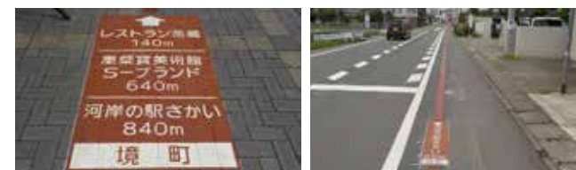
施工された誘導案内シート
