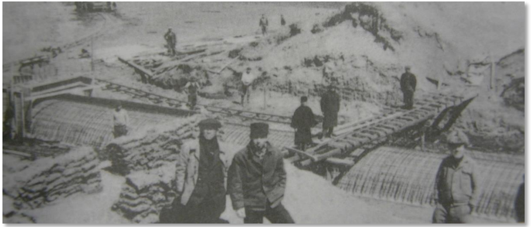
干拓工事の様子▶
