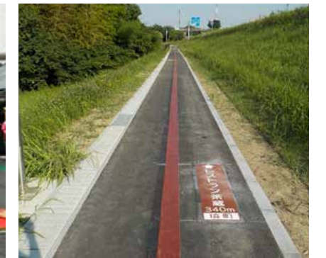
完成した遊歩道
