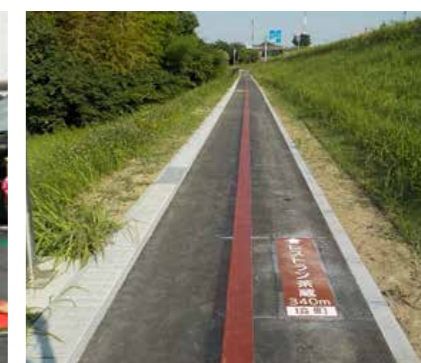
完成した遊歩道
