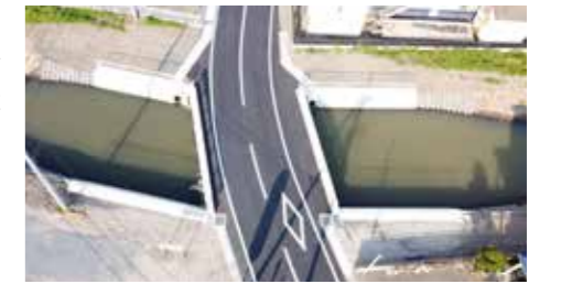
上空からの染谷川橋梁
