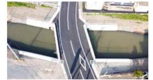
上空からの染谷川橋梁
