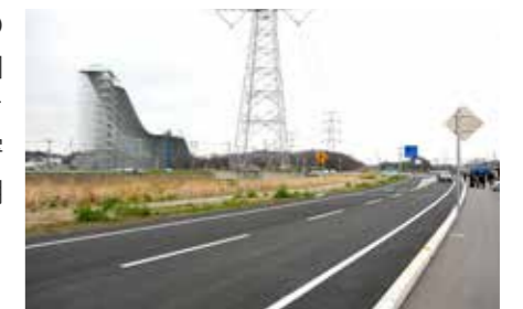
開通した国道 354 号境岩井バイパス
