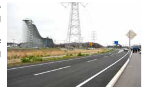
開通した国道 354 号境岩井バイパス
